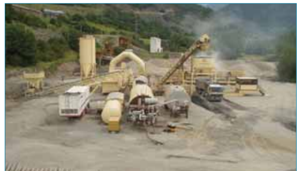
Foto 1. Vista de la planta.
