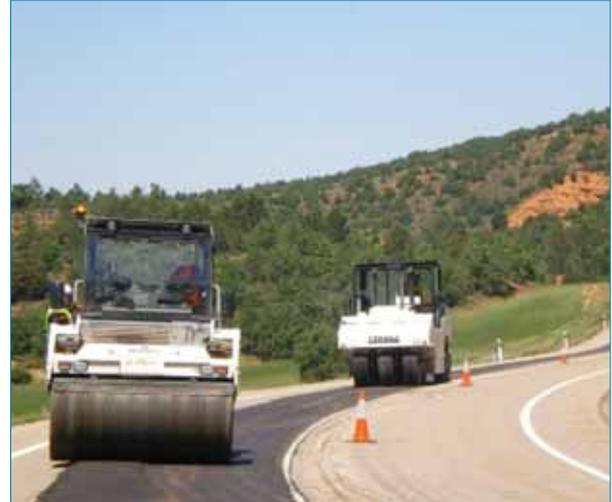
Figura 5: Compactador metálico y neumático.
