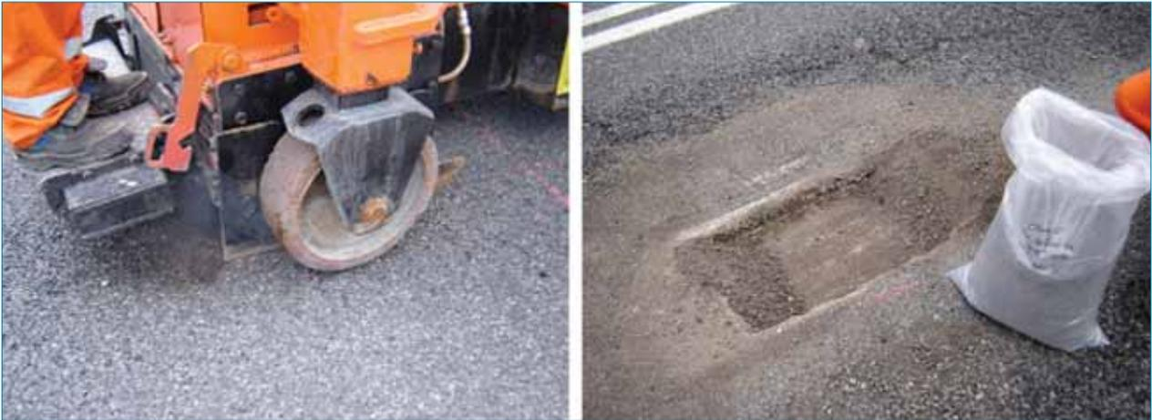
Figura 2: Toma de muestras mediante fresadora.
