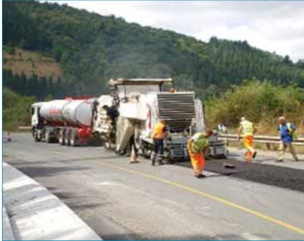
Figura 4: Recicladora mezcladora con regla de extensión y precompactación.
