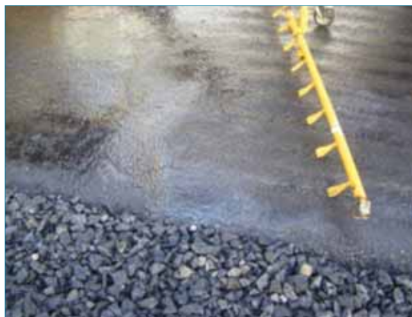
Fig. 3. Puesta en obra con lluvia persistente. Barra de soplado desplazando agua caída.
