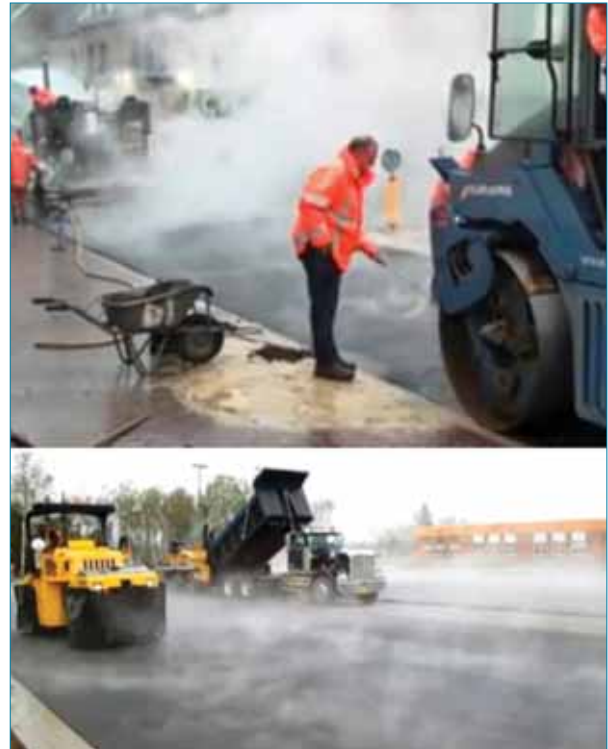
Fig. 1. Lluvia sobre la capa en ejecución de mezclas en caliente y su evaporación
