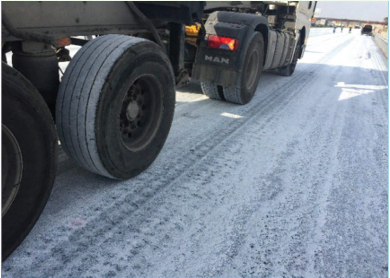
Foto 1. Aspecto de la obra tras la aplicación de la leche de cal.
