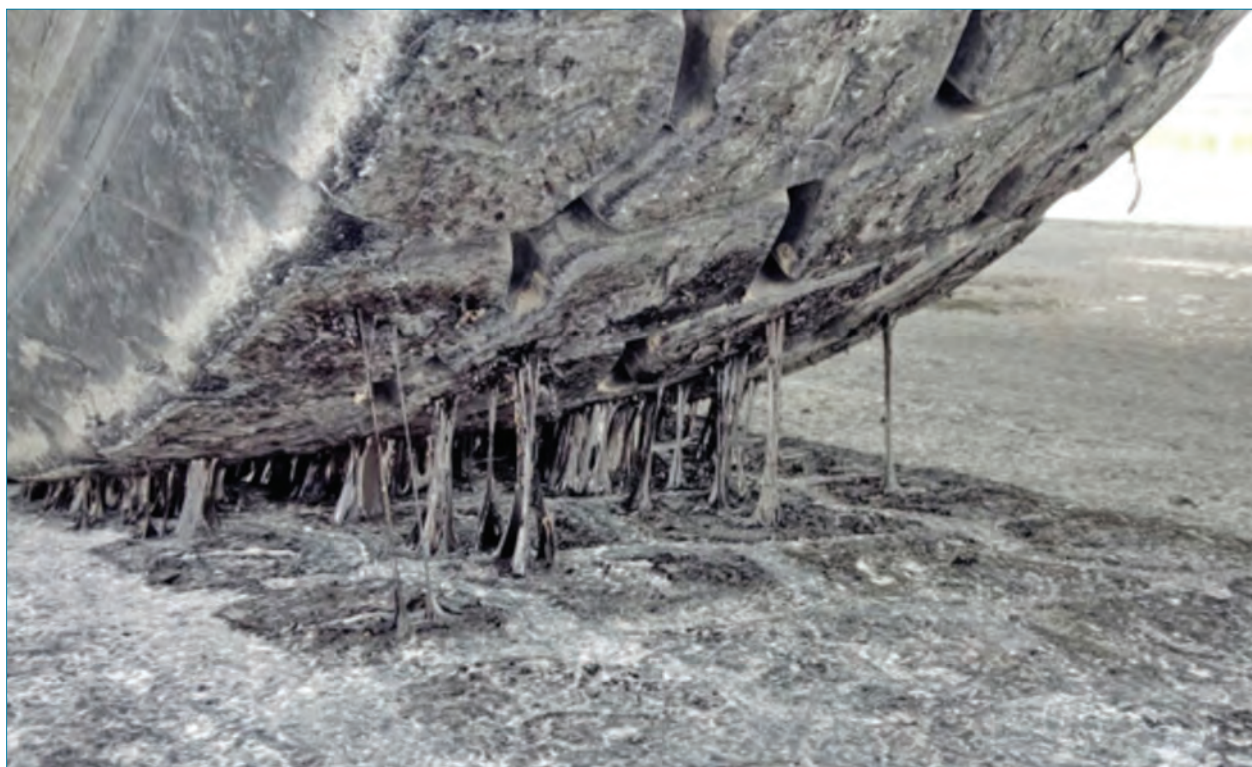
Foto 2. Adherencia de parte del riego con C60BP3 ADH (antigua ECR-1-m) a los neumáticos
