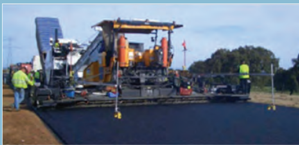
Vigas de nivelación
