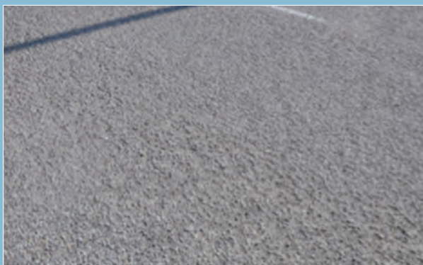
Desgranamiento generalizado
