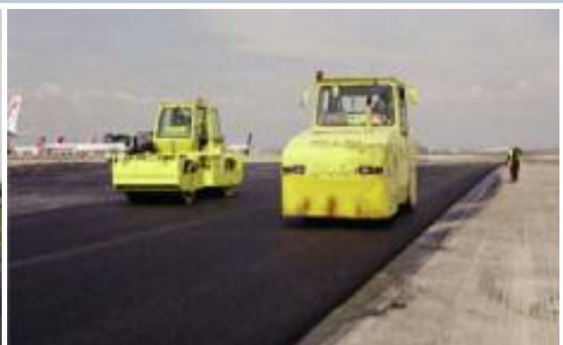
Compactación con rodillos metálicos lisos sobre mezclas bituminosas discontinuas en pista de aeropuerto y utilización final de un compactador de neumáticos.
