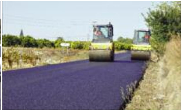
Compactación con rodillos metálicos lisos sobre mezclas bituminosas discontinuas.
