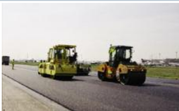
Compactación con rodillos metálicos lisos sobre mezclas bituminosas discontinuas en pista de aeropuerto y utilización final de un compactador de neumáticos.
