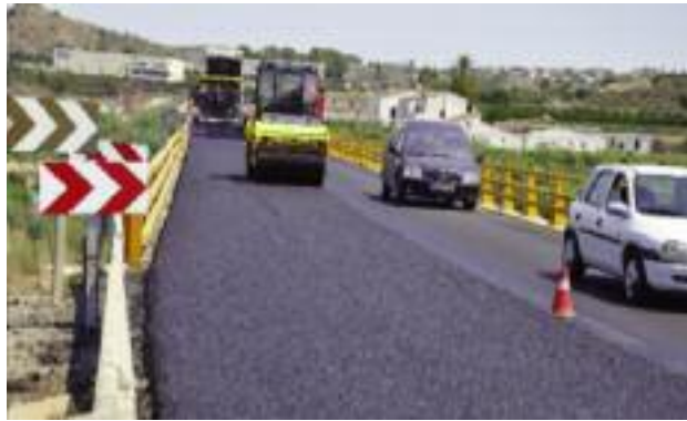
Compactación con rodillos metálicos lisos sobre mezclas bituminosas discontinuas.
