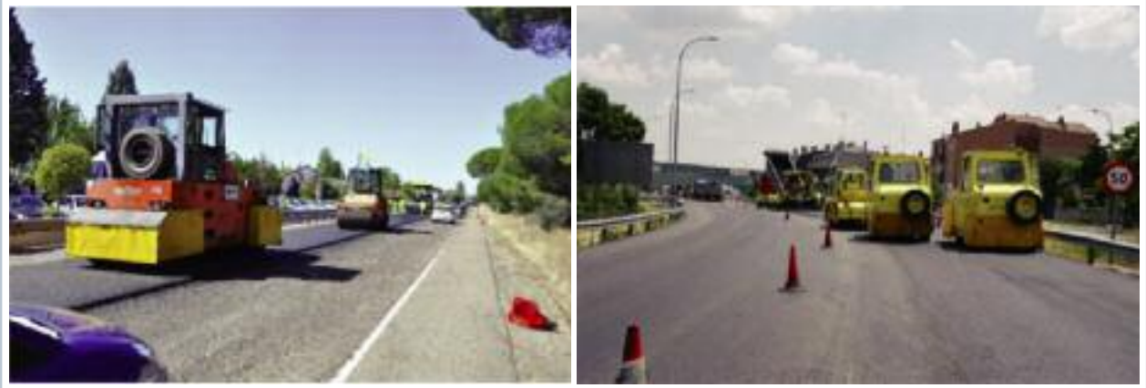
Equipos de compactación con diferentes configuraciones y número de máquinas.
