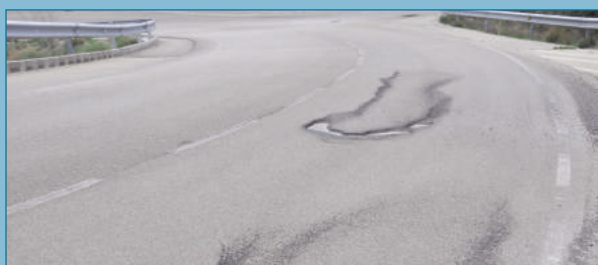
Figura 38. Fisura parabólica.
