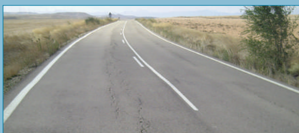
Figura 37. Fisura errática.
