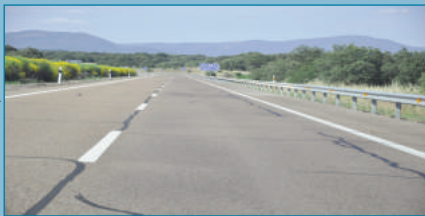
Figura 51. Sellado de grietas reflejadas
