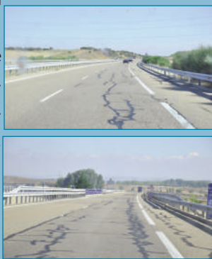
Figura 47 . Sellado de las grietas existentes.
