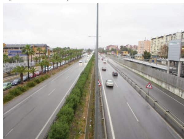
Figura 1. Estado inicial del tramo piloto previo al reasfaltado con las mezclas LIFE-SOUNDLESS.
