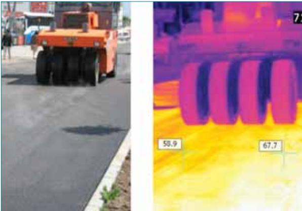
Figura 8. MBT: Termografía de la temperatura de la mezcla durante la compactación con neumáticos.
