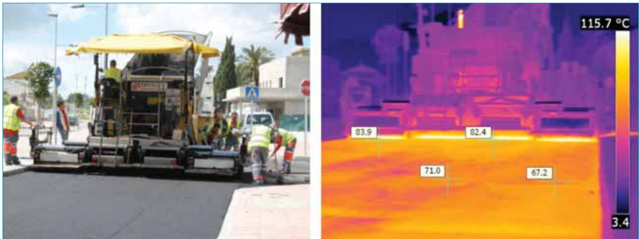
Figura 6. MBT: Termografía de la temperatura de la mezcla templada recién extendida.
