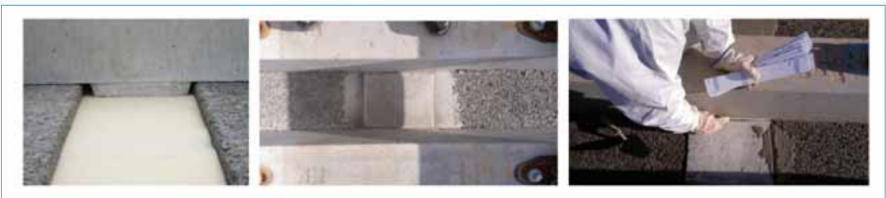
Figura 15. Fotografías del relleno intertraviesa.
