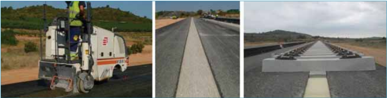
Figura 14. Fotografía de proceso de fresado y colocación de la traviesa.
