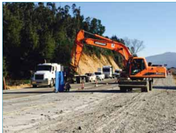
Foto 8. Desintegración de doble losa de hormigón. Paso 1: Disminución de la rigidez de la losa mediante taladro.
