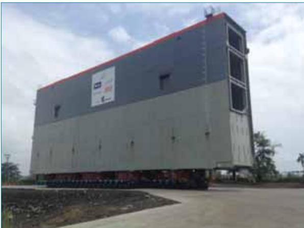
Foto 15. Rodaje de una compuerta sobre la carretera de acceso a la esclusa.
