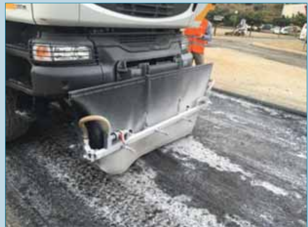
Foto 4. Detalle de la adaptación de la máquina de salmuera para el extendido de la leche de cal.
