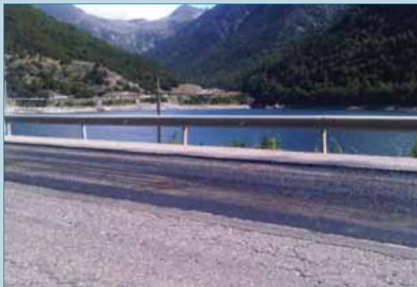
Foto 1. Detalle del traslado de betún, en la zona de rodadura, sobre una superficie regada con un riego de adherencia en la que los neumáticos han levantado la emulsión extendida.
