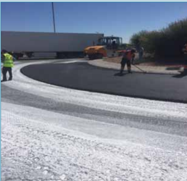
Foto 6. Detalle de la leche de cal y de las operaciones del extendido de la mezcla bituminosa en la carretera N-230. Tramo: Travesía de Almenar.
