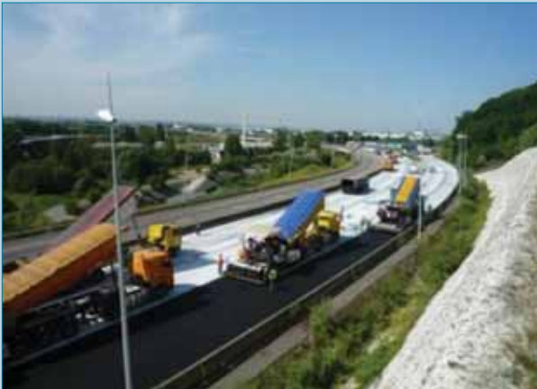
Foto 3. Puesta en obra de mezclas bituminosas con riego de adherencia tratado con leche de cal en la autopista A-29 en Francia (foto cedida por Lhoist).
