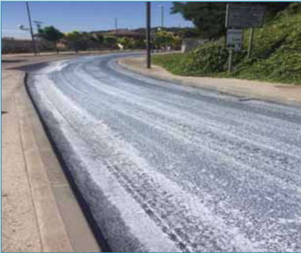
Foto 5. Detalle de la leche de cal encima del riego de adherencia en la carretera N-230. Tramo: Travesía de Almenar.
