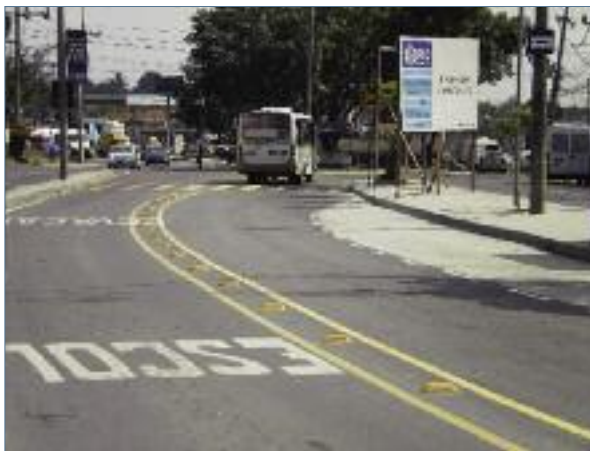
Fotos durante a execução e após conclusão.
