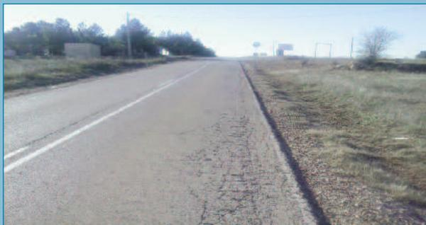
Figura 13. Rodera formada por asentamiento de las capas granulares inferiores del firme.
