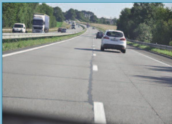
Figura 8. Grietas reflejadas de las existentes por retracción en las capas inferiores del firme.
