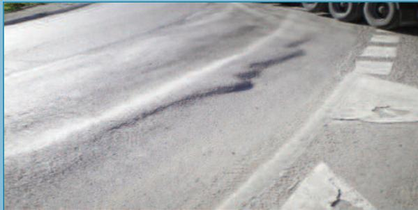
Figura 10. Roderas con deformación plástica de la mezcla bituminosa.
