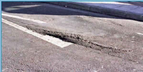
Figura 11. Deformación por vertido de combustibles que altera sensiblemente la mezcla bituminosa.
