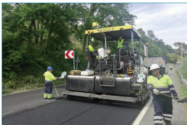
Figura 14. Ubicación en una extendidora de un equipo de escaneo IR a ancho completo. Fuente MOBA
