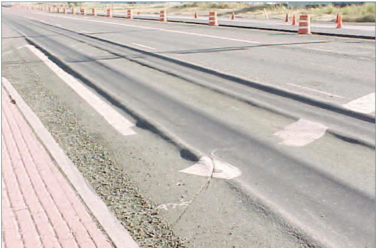
Ilustración 1: Deformación plástica (roderas)
