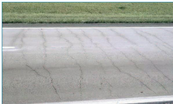
Ilustración 3: Fisuración térmica
