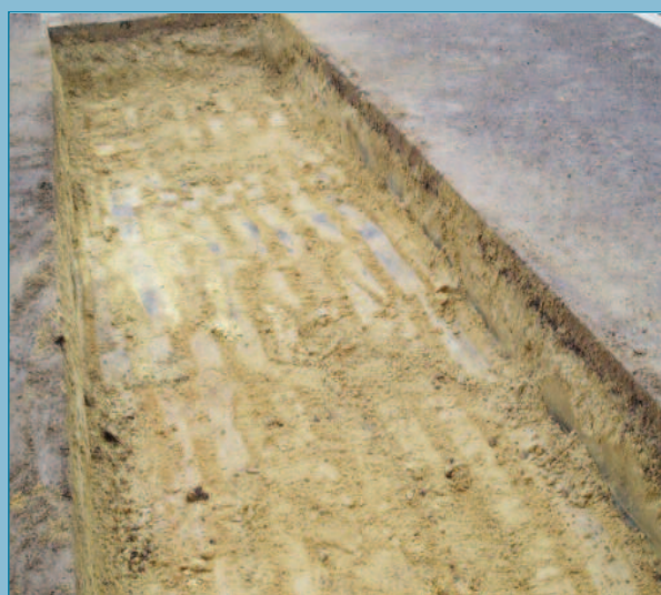
Figura 113. Fresado de la capa bituminosa y eliminación de la capa inferior de zahorra plástica, reposición de esta que posteriormente se cubrirá con una capa de rodadura bituminosa.
