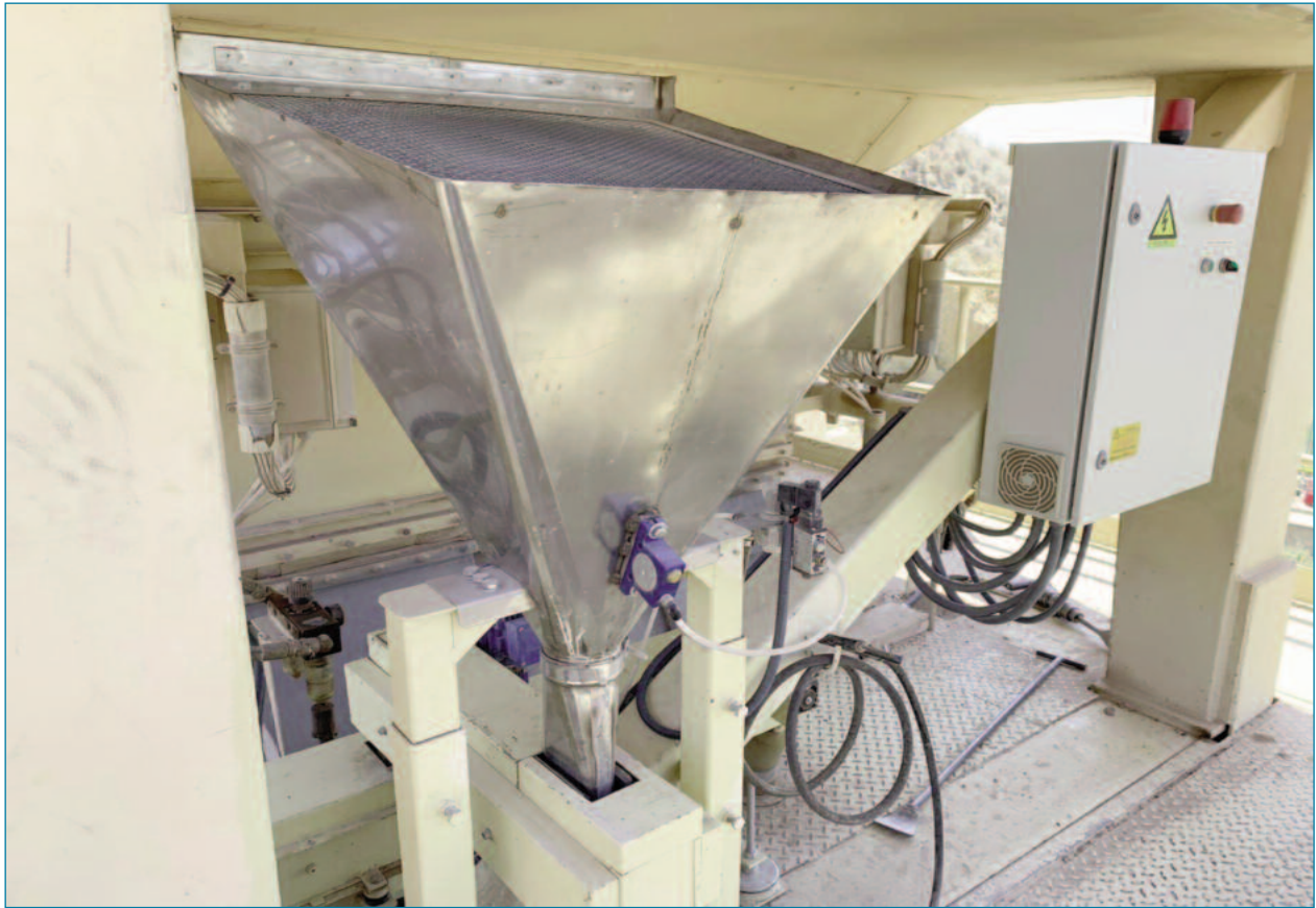
Figura 4. Sistema de dispensación de aditivo en base grafeno en planta
