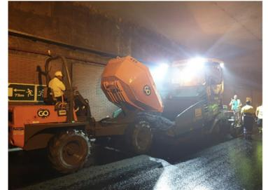
Dada la limitada altura del túnel, la mezcla se introdujo en un silo móvil de transferencia SB2500E para su homogeneización y posteriormente se introdujo en el túnel por medio de vehículos dumper de alta capacidad.
