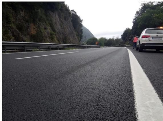
Se fabricó una mezcla tipo AUTL 8 utilizando una arena 0-2 mm de naturaleza ofítica (árido fino) y un arrocillo de tamaño 4/8 mm de naturaleza siderúrgico (árido grueso). Los ensayos realizados para la caracterización de los áridos finos, fueron la densidad, absorción y equivalente de arena. Los áridos gruesos fueron de naturaleza siderúrgica, que aportan resistencia al conjunto de la estructura pétreo y características su-
